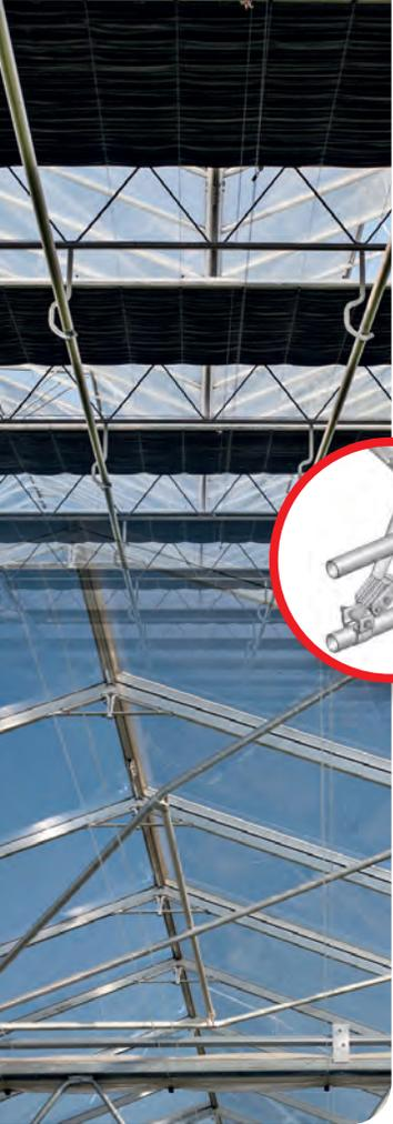
StabiMaxTwin推杆开窗系统具有独特的结构，其推拉杆（用于单独控制两块通风区域）并排安装在桁架上，这样可使两组推杆（分别从最上端和最下端）相互移动，并且使幕布可以自由地安置在桁架上。
